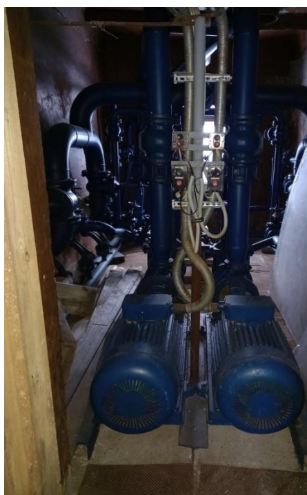
Рис. 6.26. Противопожарные насосы К100-65-250
