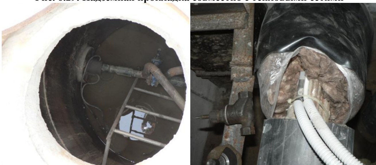
Рис. 6.29. Надземная прокладка совместно с тепловыми сетями
