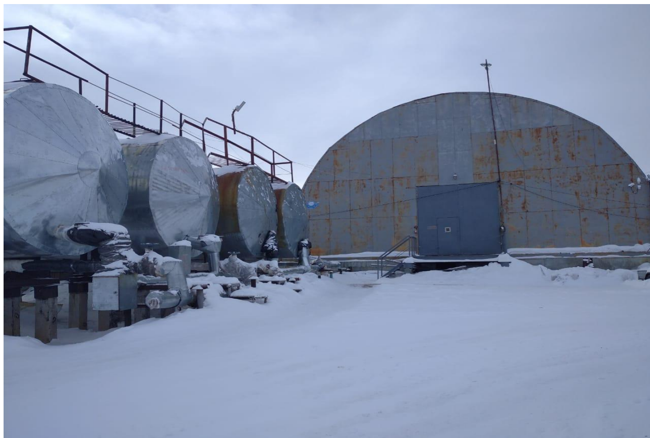
Рис. 6.23. Резервуары чистой воды на площадке ВОС-50
