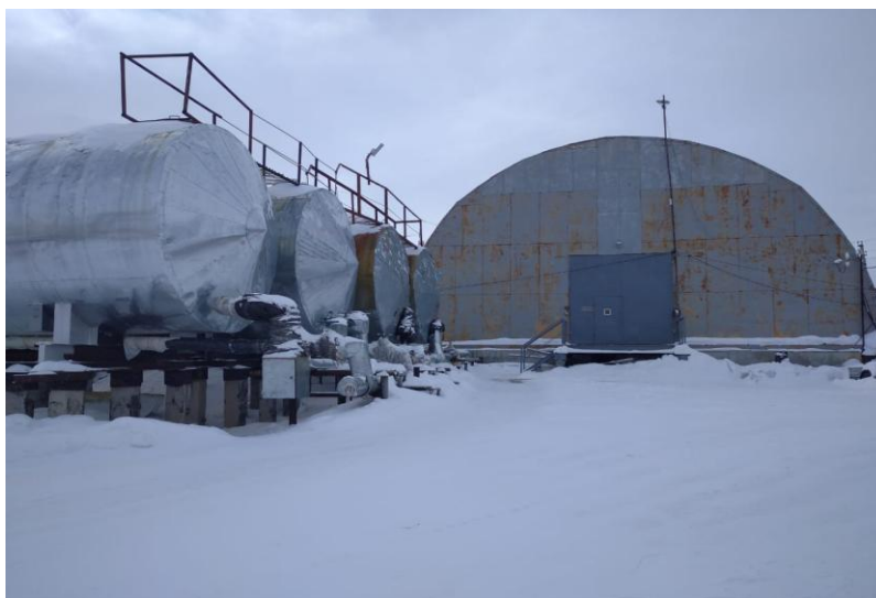
Рис. 6.5. Здание водоочистных сооружений ВОС-50 с. Аксарка
