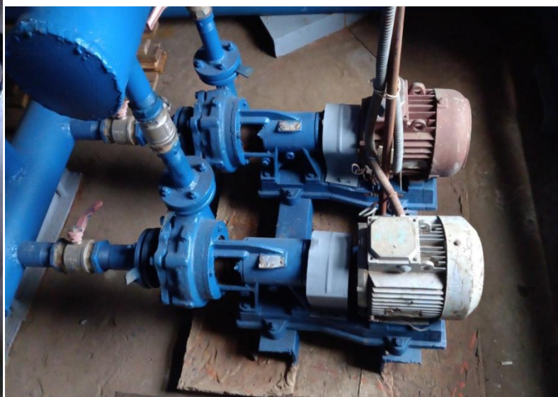
Рис. 6.27. Циркуляционные насосы К 20/30
