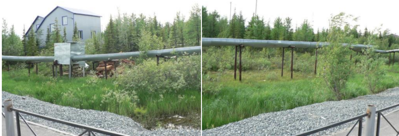
Рис. 6.29. Надземная прокладка совместно с тепловыми сетями
