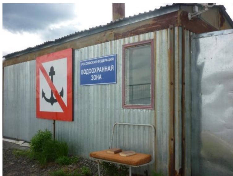
Рис. 6.1. Здание насосной станции 1-го подъема
