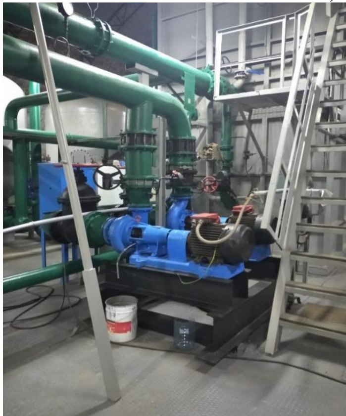
Рис. 6.10. Промывочные насосы К200-150-250С УХ , К290/18-УХЛ4
