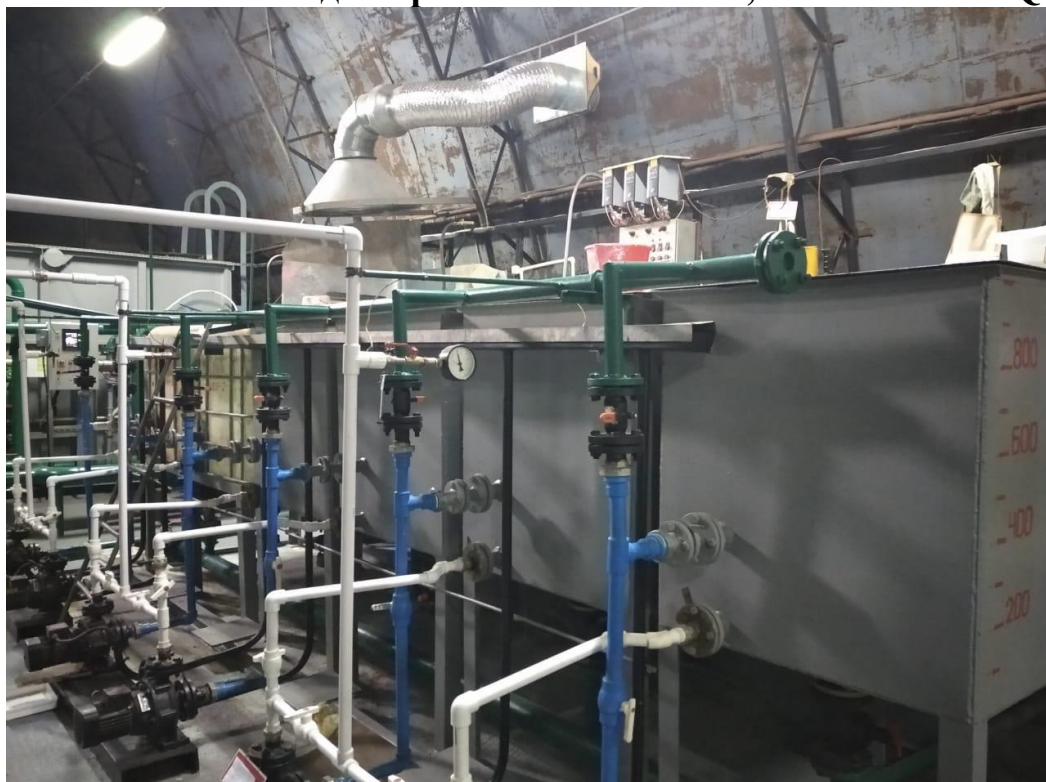
Рис. 6.12. Насосы подачи реагентов NB32-160,1/172 А-Ф-А ВАQE
