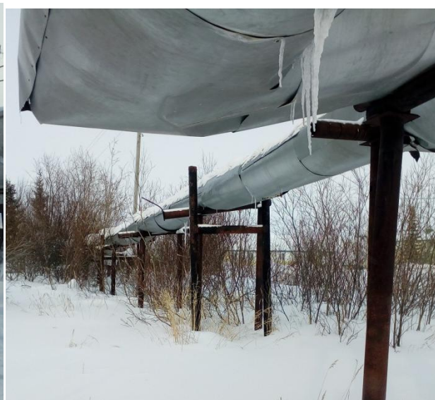
Рисунок 101. Результат затопления сетей из-за утечки водопровода на участке ТК56 – ТК2.
