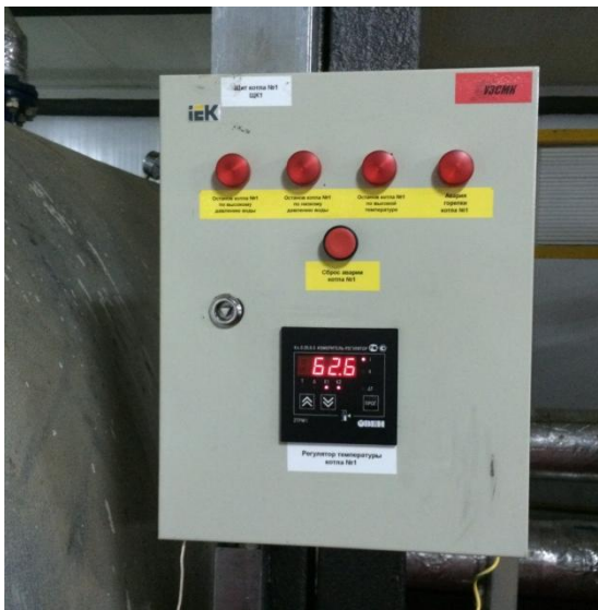
Рисунок 62. Пульты управления котлами №1 и №2.
