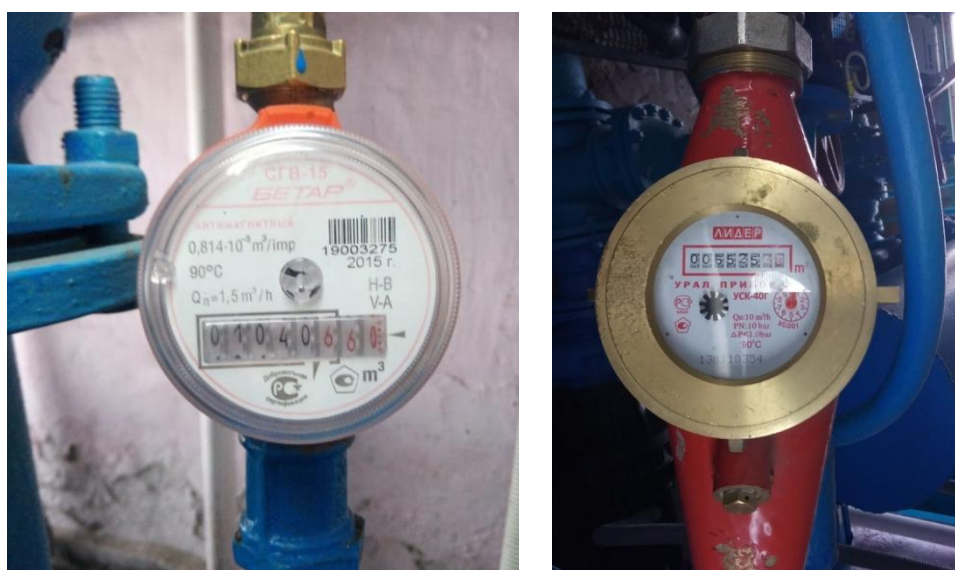
Рисунок 58. Счетчики воды на основной и резервной линиях.
