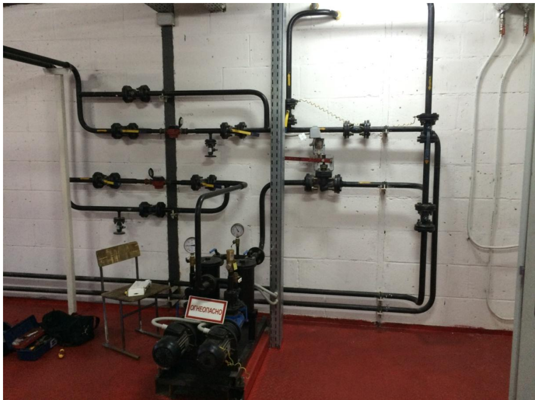
Рисунок 67. Топливные насосы.
