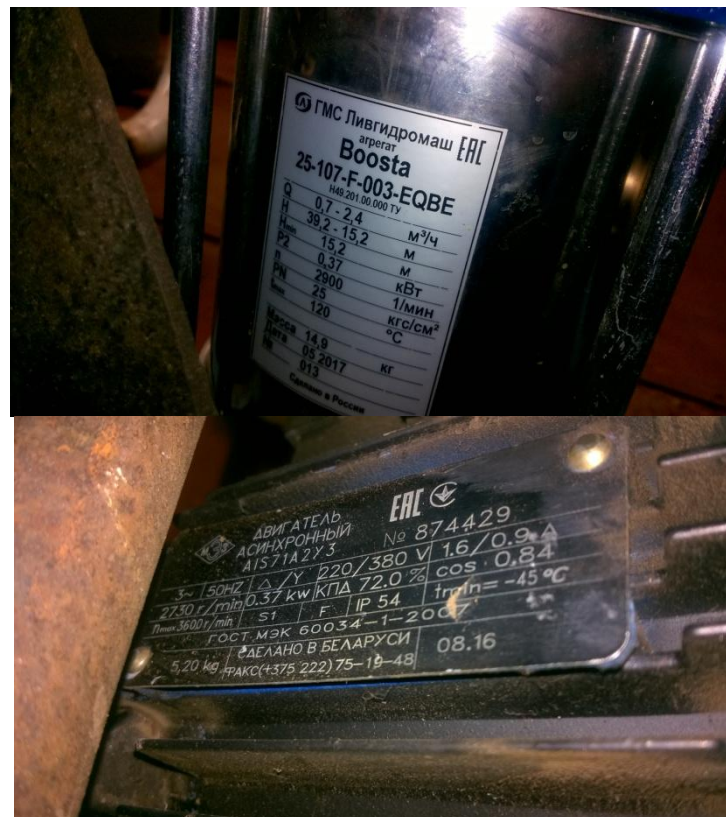
Рисунок 86. Подпиточный насос №1.
