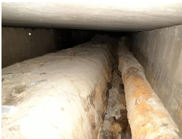
Рисунок 94. Результат затопления сетей подземной прокладки на участке ТКЗВ – ул. Ямальская 15.
