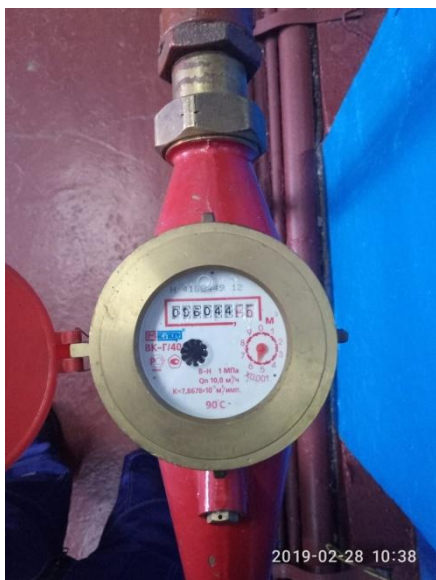
Рисунок 32. Счетчики воды на основной и резервной линиях.
