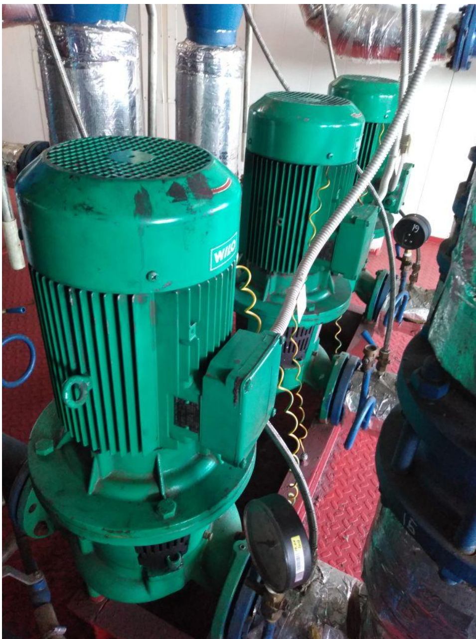
Рисунок 66. Сетевые насосы внешнего контура №1, 2, 3.
