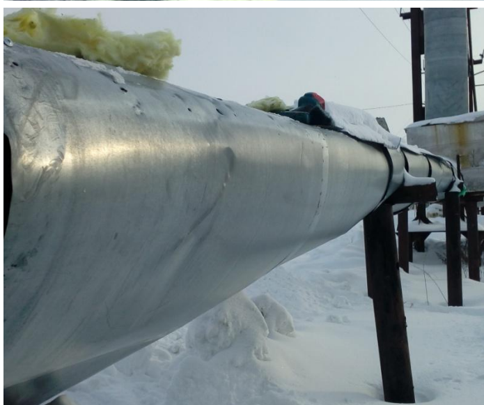
Рисунок 101. Результат затопления сетей из-за утечки водопровода на участке ТК56 – ТК2.
