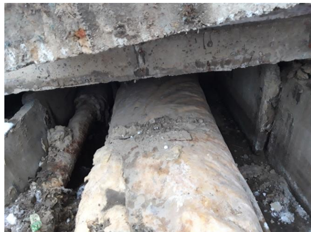
Рисунок 94. Результат затопления сетей подземной прокладки на участке ТКЗВ – ул. Ямальская 15.
