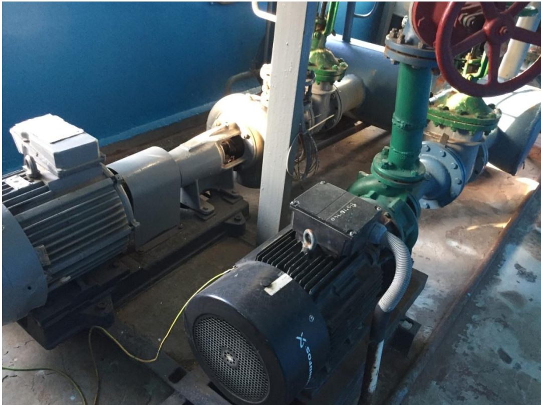
Рисунок 28. Сетевые насосы №1, 2.
