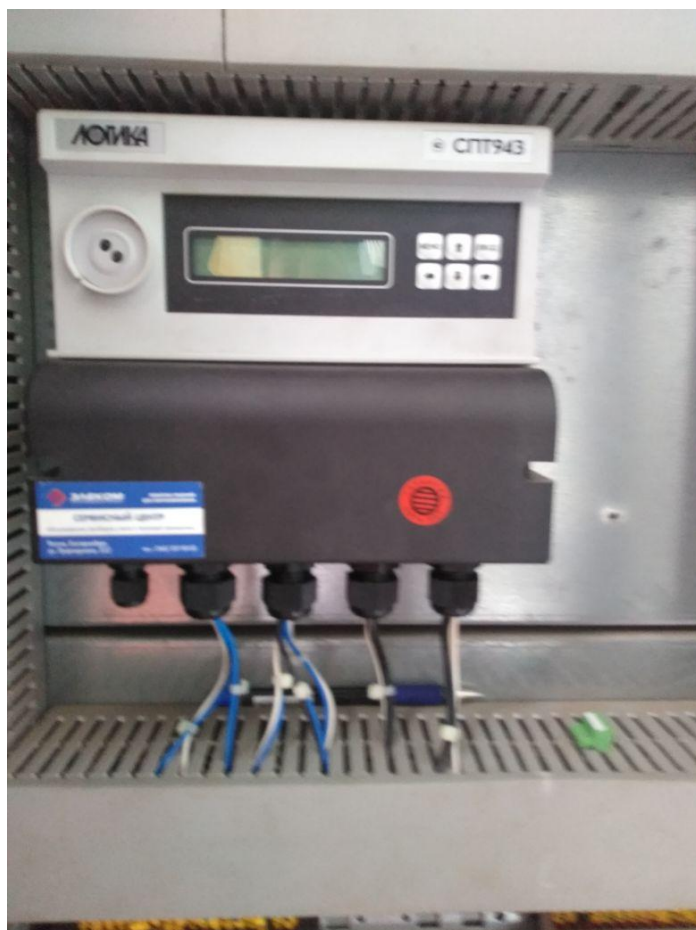
Рисунок 71. Тепловычислитель для контроля параметров теплоносителя.
