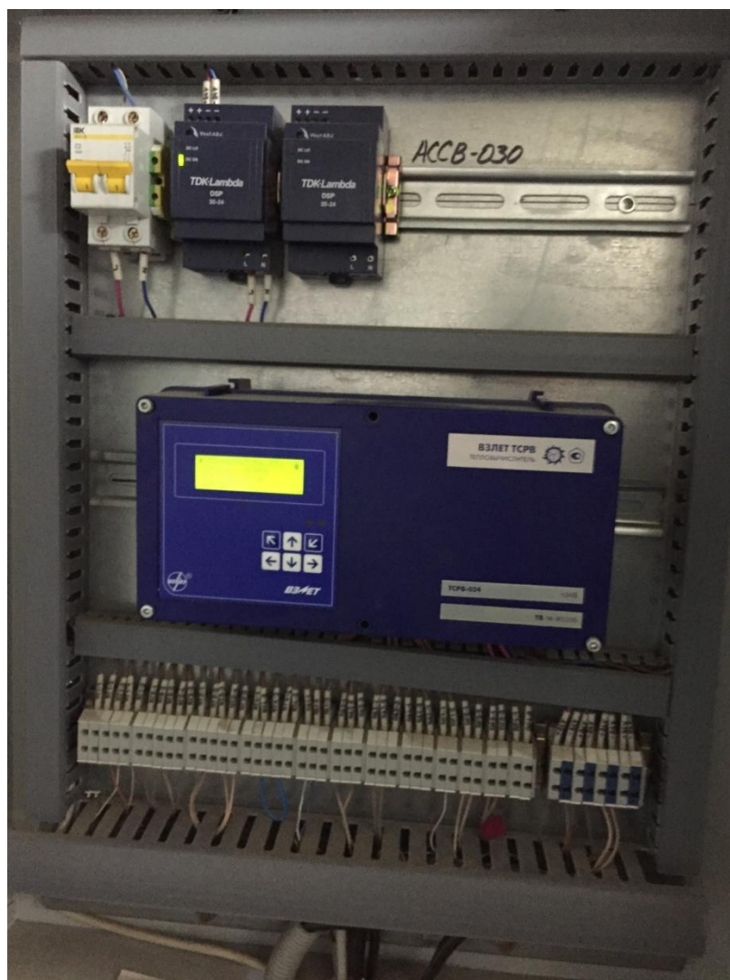
Рисунок 57. Тепловычислитель Взлет для контроля параметров теплоносителя.
