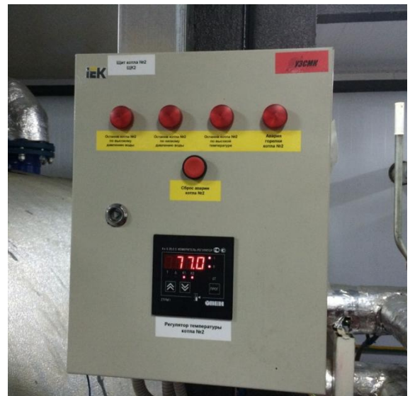
Рисунок 62. Пульты управления котлами №1 и №2.
