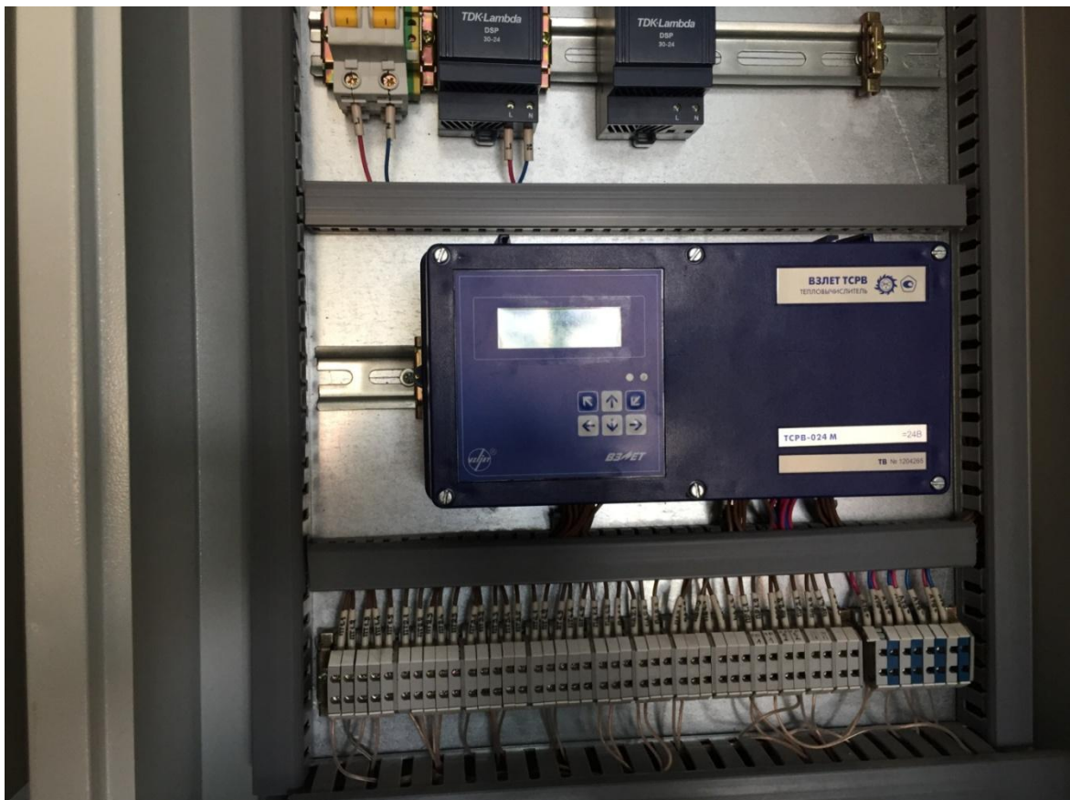
Рисунок 31. Тепловычислитель Взлет для контроля параметров теплоносителя.
