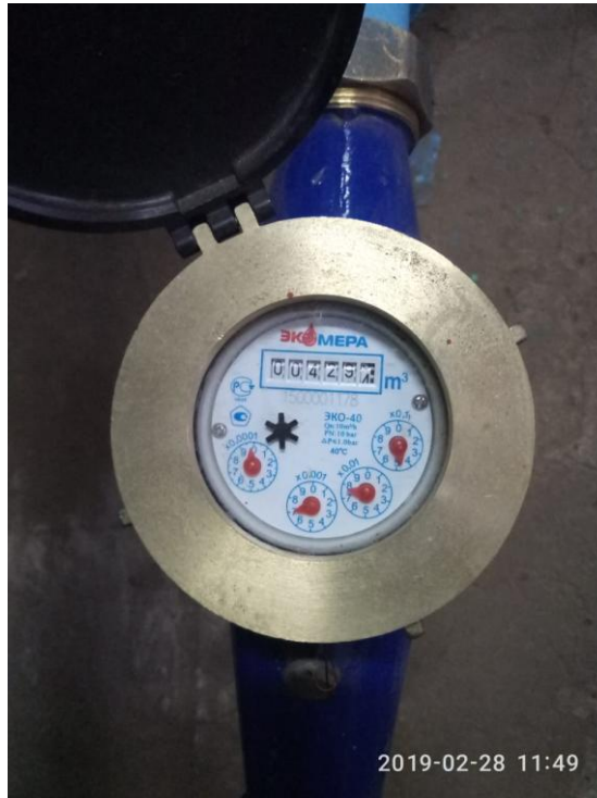
Рисунок 46. Счетчик воды.
