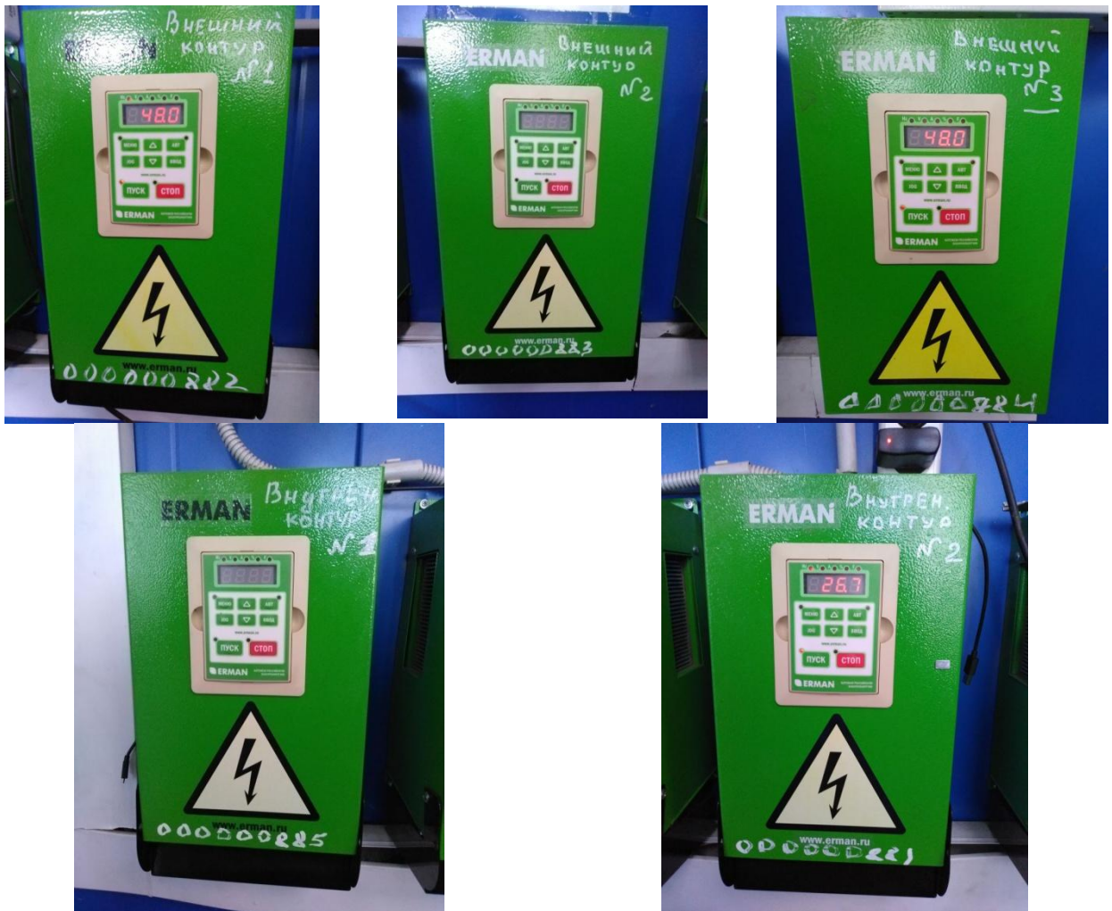
Рисунок 69. Частотные преобразователи сетевых насосов.
