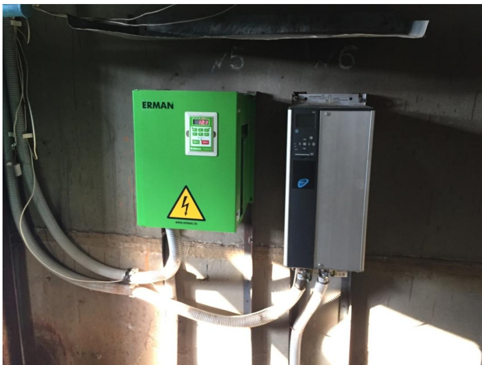
Рисунок 43. Щит управления насосами, частотный преобразователь сетевых насосов №5 и №6.
