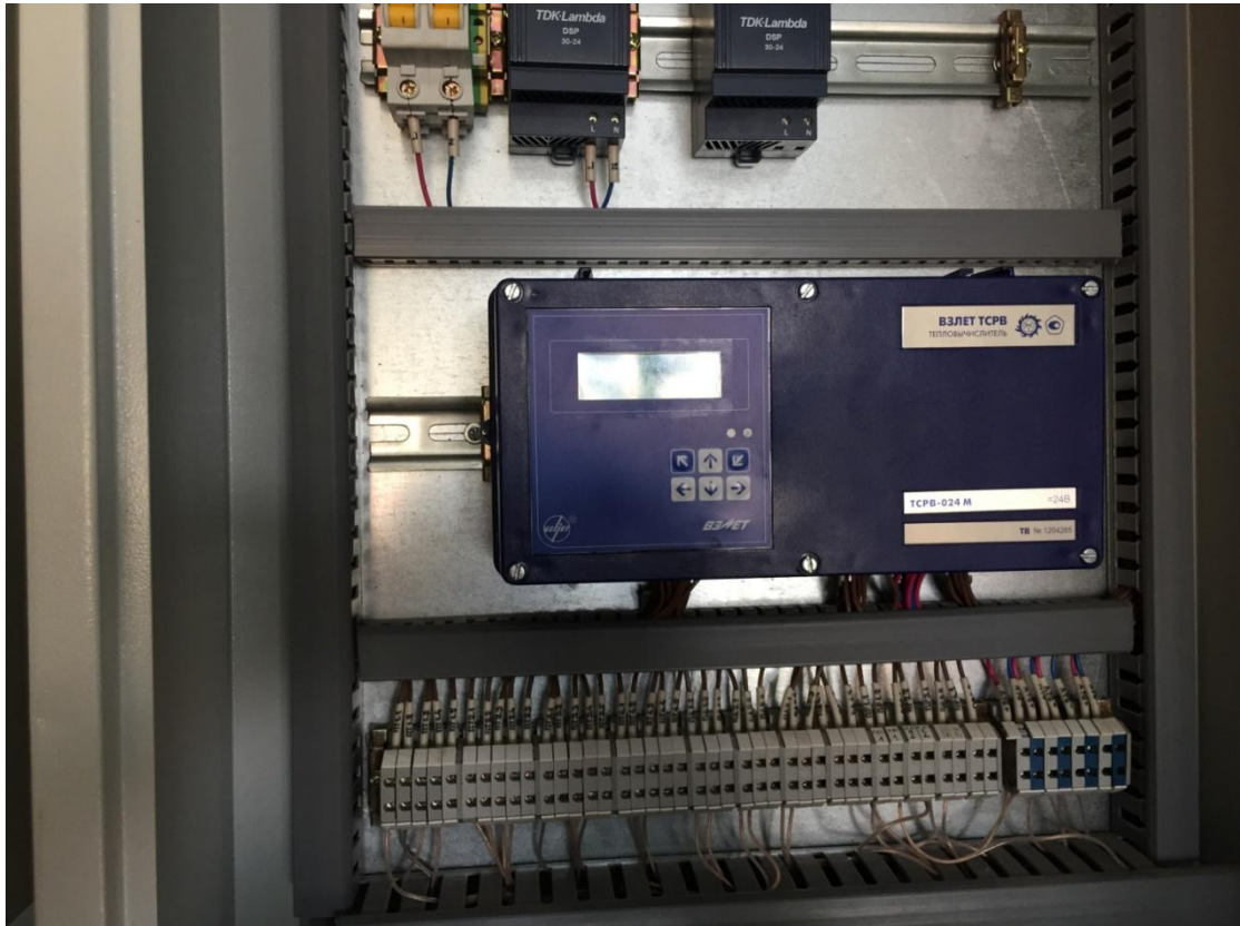
Рисунок 45. Тепловычислитель Взлет для контроля параметров теплоносителя.
