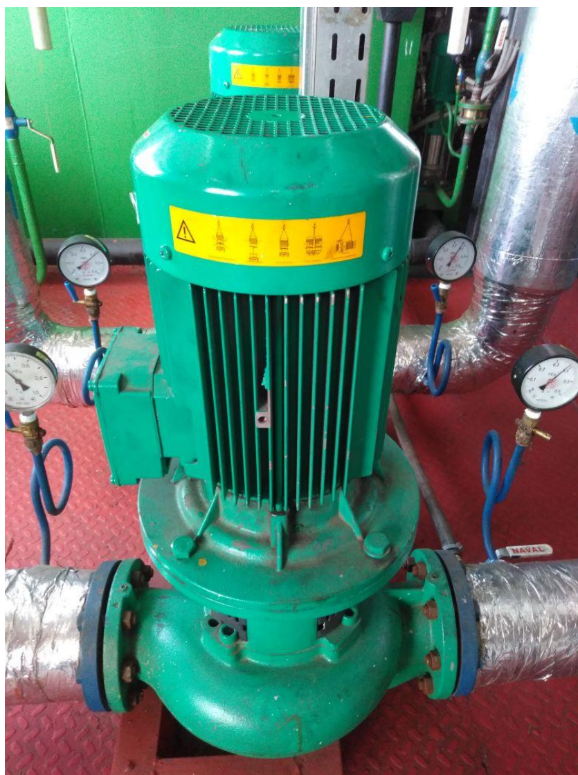
Рисунок 65. Сетевые насосы внутреннего контура №1, 2.
