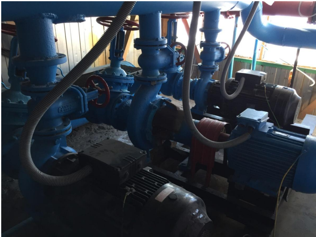
Рисунок 55. Сетевые насосы №1,2,3.
